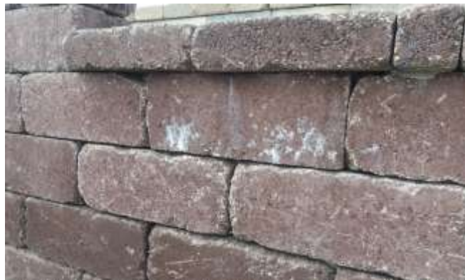
vápenný výkvet na plote
