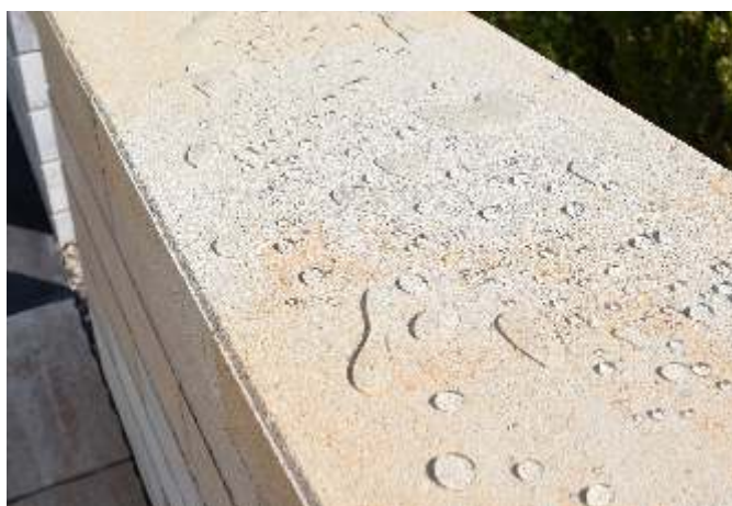
ochranná vrstva po aplikácii zabraňuje prenikaniu nečistôt
