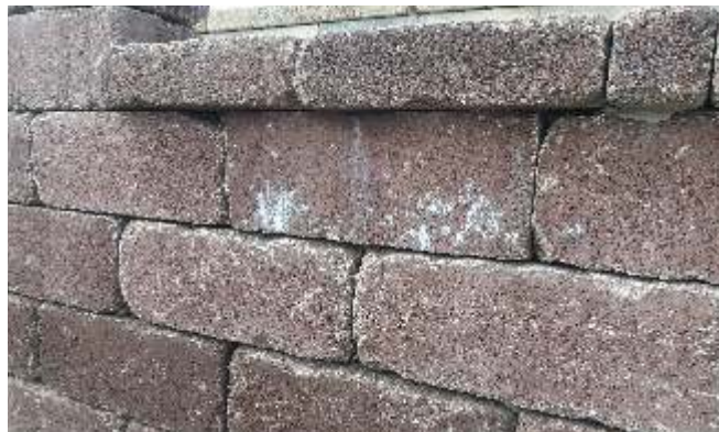
vápenný výkvet na plote
