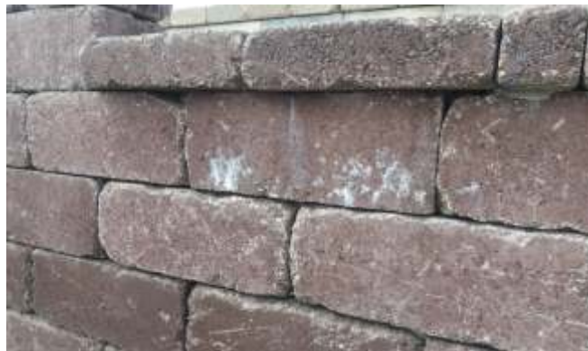
vápenný výkvet na plote
