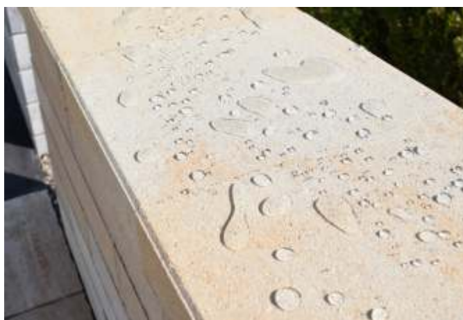
ochranná vrstva po aplikácii zabraňuje prenikaniu nečistôt
